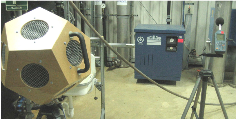
Schallmessung in einer Technikzentrale
