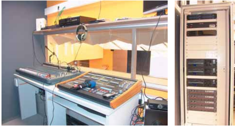
Links: Blick in die Tonregie, rechts: Audiorack mit Biamp Nexia und alcons audio System-Amps
